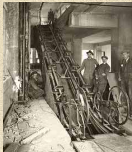
Первый эскалатор в Финляндии был установлен в универсаме Stockmann. Он был изготовлен немецкой компанией Karl Flohr AG, но установлен в 1930 году компа- нией KONE
